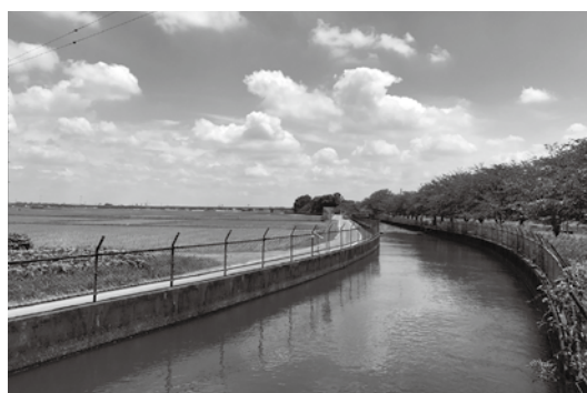
取水量37m 3 /sの水量をほこり、埼玉県東部の田んぼを潤す見沼代用水（基幹線 久喜市）
