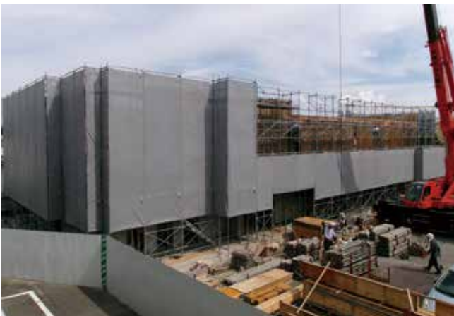
建設中の岩槻城南支店
